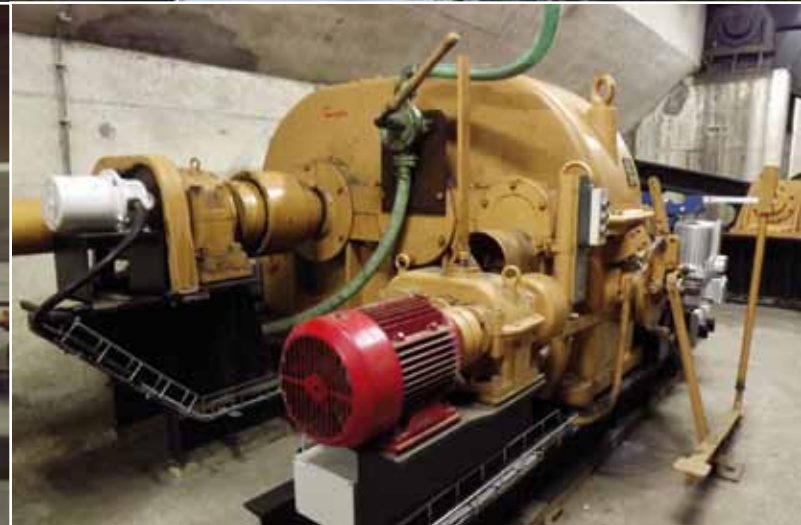
afb.33. Noodmotor en voetbediende rem © WvS
