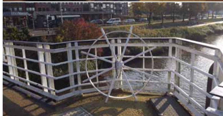
afb.28. Lokale bedieningslessenaar © WvS afb.29. Panamawiel aandrijving val © WvS afb.30. Handaandrijving van de brug © WvS
