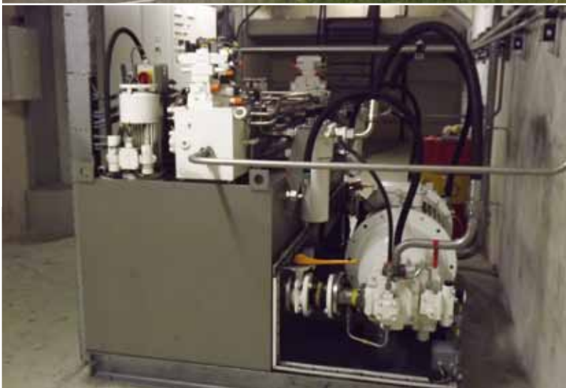
boven: afb.34. Energiebrug © WvS onder: afb.35. Hydraulisch aggregaat © WvS
