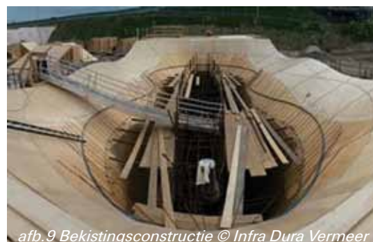
afb.9 Bekistingsconstructie © Infra Dura Vermeer
