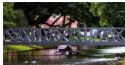
Afb.6. UHSB-brug Hoekersingel, Rotterdam
