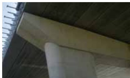
Afb.3. onderzijde aanbrug. Let op verzorgde overgang pijlerkolom en pijlerbalk
