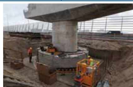
Afb.5. Pijler Westrandweg A5 voor het boven de weg draaien van de pijlerbalk
