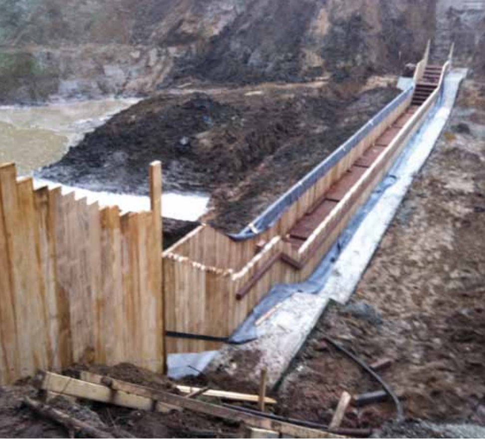
afb.4. De damwanden zijn ingeheid en bevestigd.
