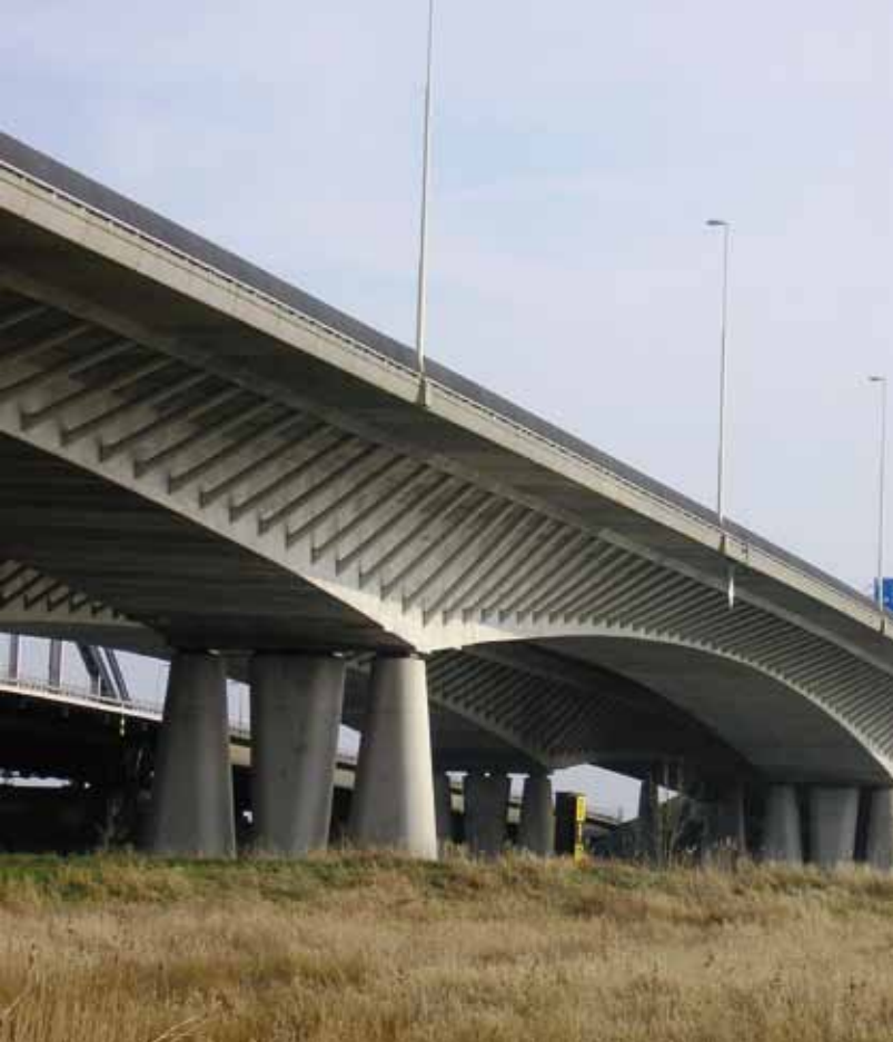
4 .Jan Blankenbrug bij Vianen in de A2, betonnen kokers met schoren
