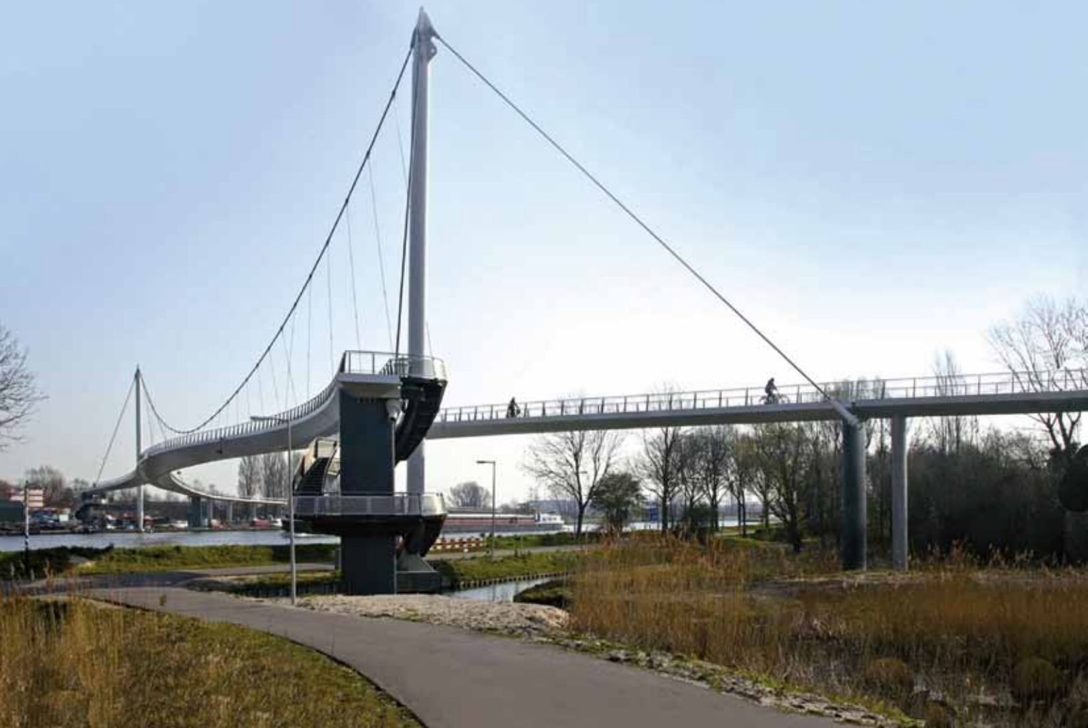
10. Nesciobrug, stalen hangbrug voor langzaam verkeer over het Amsterdam-Rijnkanaal, Amsterdam
