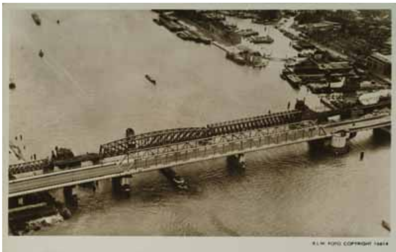
8. Plaatsen van de tweede hoofdlijger van de Waterloo Bridge in de spoorbrug over de Oude Maas bij Dordrecht 8a. Foto van DiEP Erfgoedcentrum Dordrecht. 9. Zijaanzicht van Waterloo Bridge
