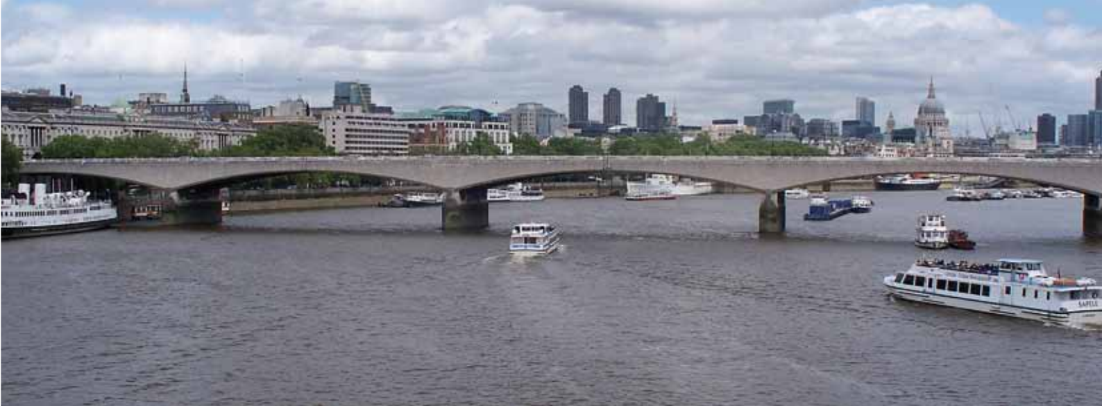
10. Tegenwoordige Waterloo Bridge 11a en b. Onderkant van de brug
