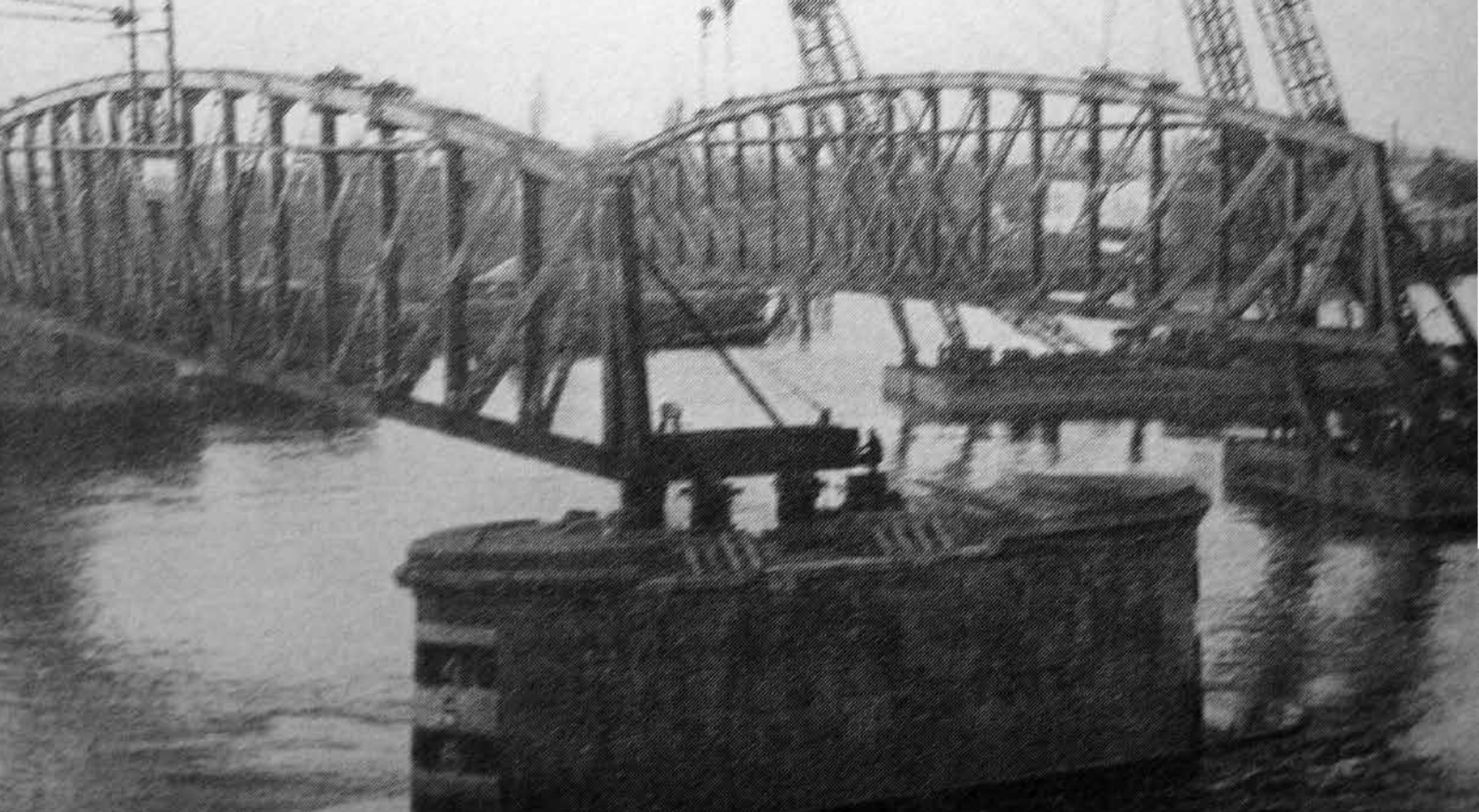
8. Plaatsen van de tweede hoofdlijger van de Waterloo Bridge in de spoorbrug over de Oude Maas bij Dordrecht 8a. Foto van DiEP Erfgoedcentrum Dordrecht. 9. Zijaanzicht van Waterloo Bridge
