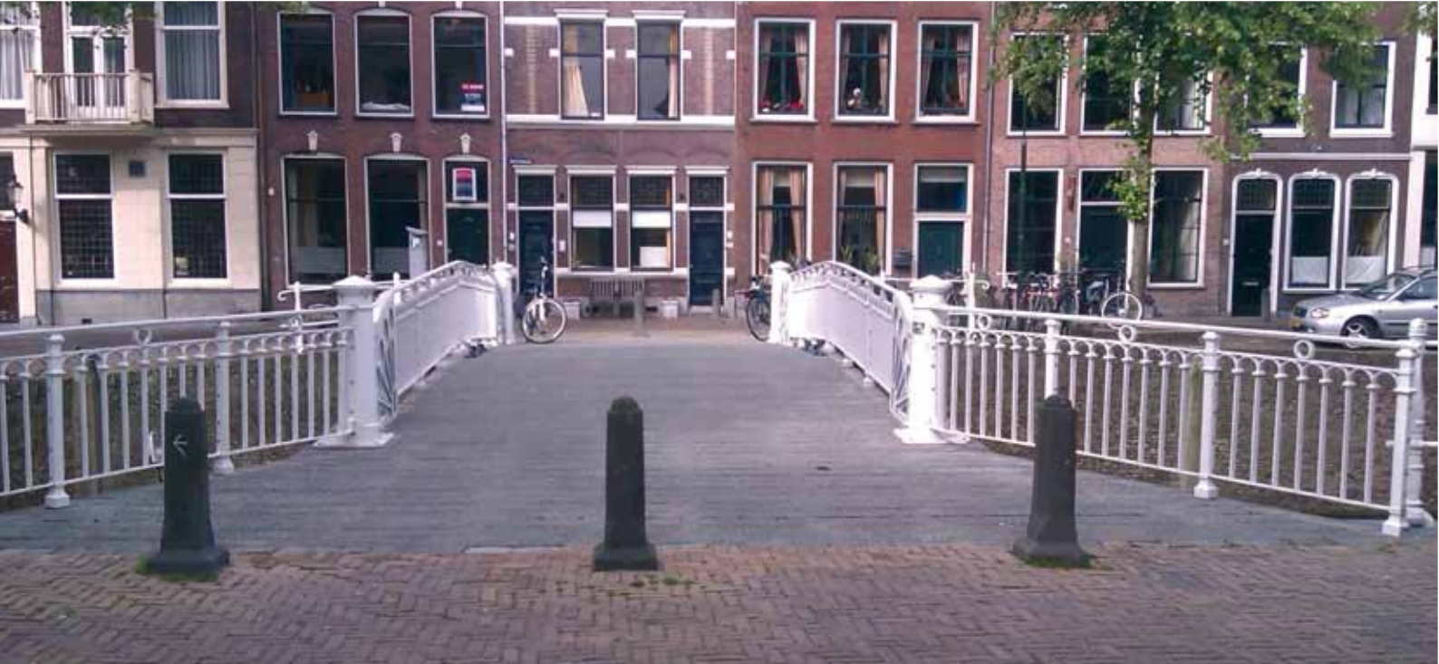
Boven: Afb. 9. Roosters houden de duiven op afstand Afb. 10. Montage van het houten dek (Azobé)
