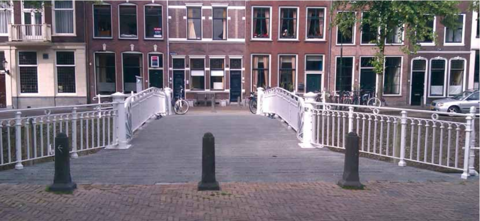
Boven: Afb. 9. Roosters houden de duiven op afstand Afb. 10. Montage van het houten dek (Azobé)
