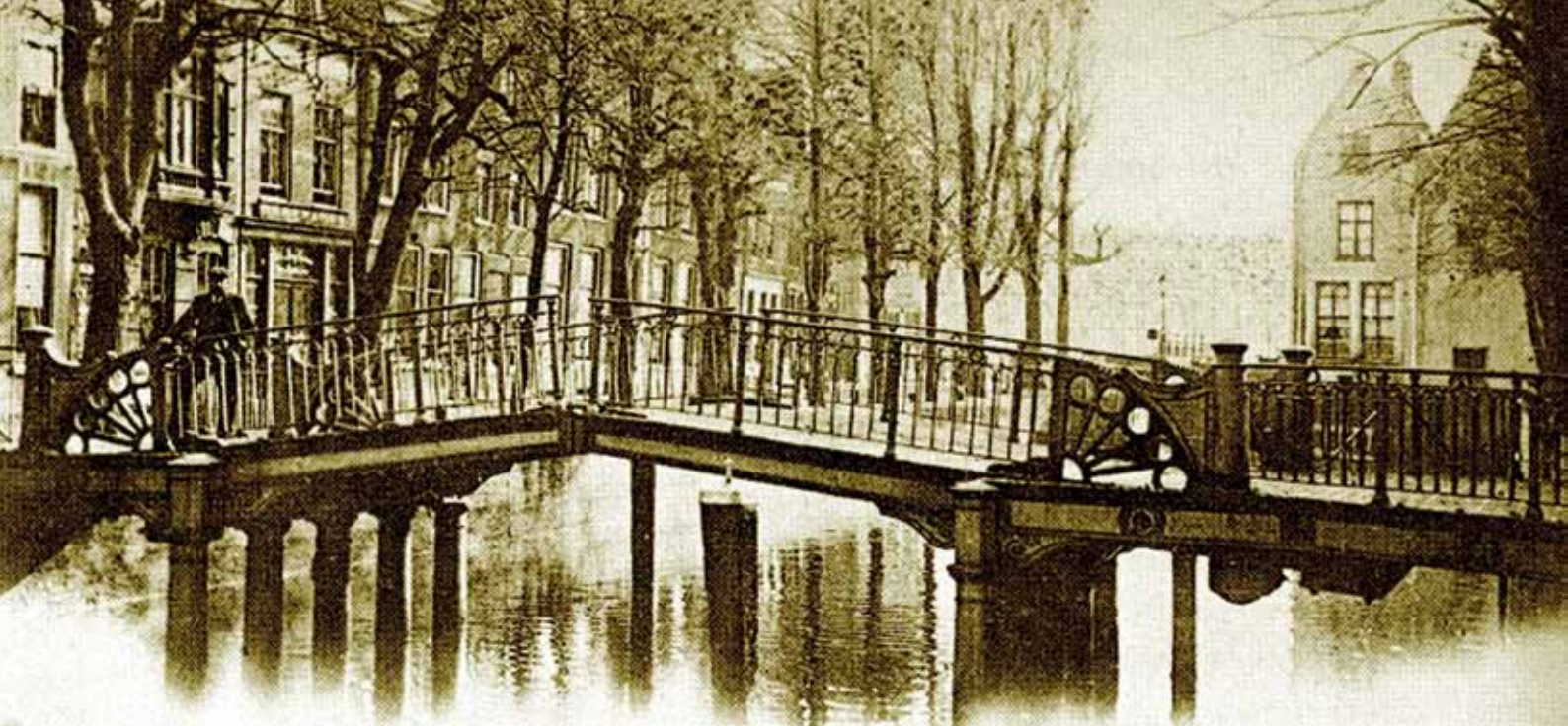
Afb. 1. De Uiterste Brug, kort na voltooiing in 1880; links de brugwachter, een trotse man bij een mooi stuk ingenieurskunst Afb. 2. Tekening van detail ter plaatse van het draaipunt
