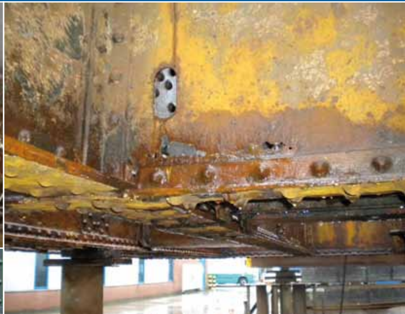
Linksboven: Schade aan flens dwarsverband rechtsboven: Schade aan het dwarsverband links: montage van de 6-armige brugdrager
