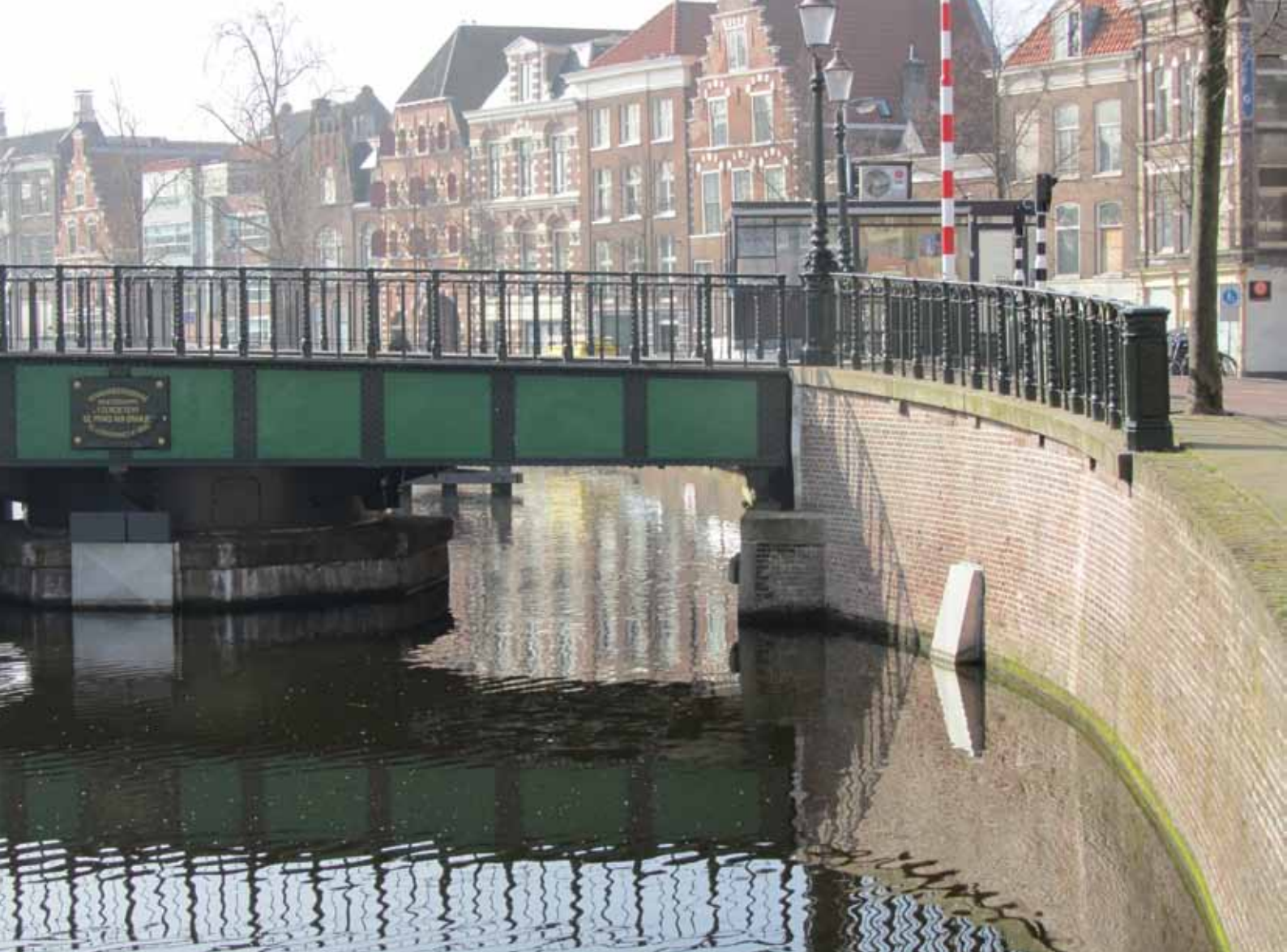
De restaureerde Melkbrug met brugwachtershuisje
