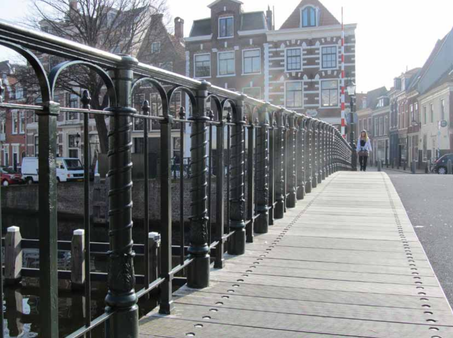
Gerestaureerde balustrade en voetpad
