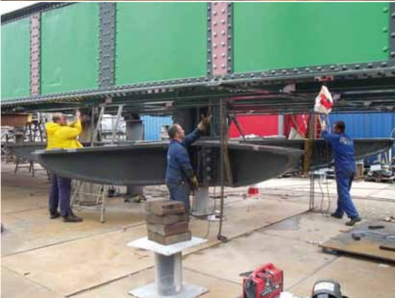
Linksboven: Schade aan flens dwarsverband rechtsboven: Schade aan het dwarsverband links: montage van de 6-armige brugdrager
