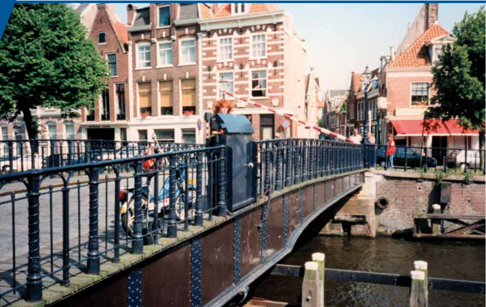
De Melkbrug voor de restauratie
