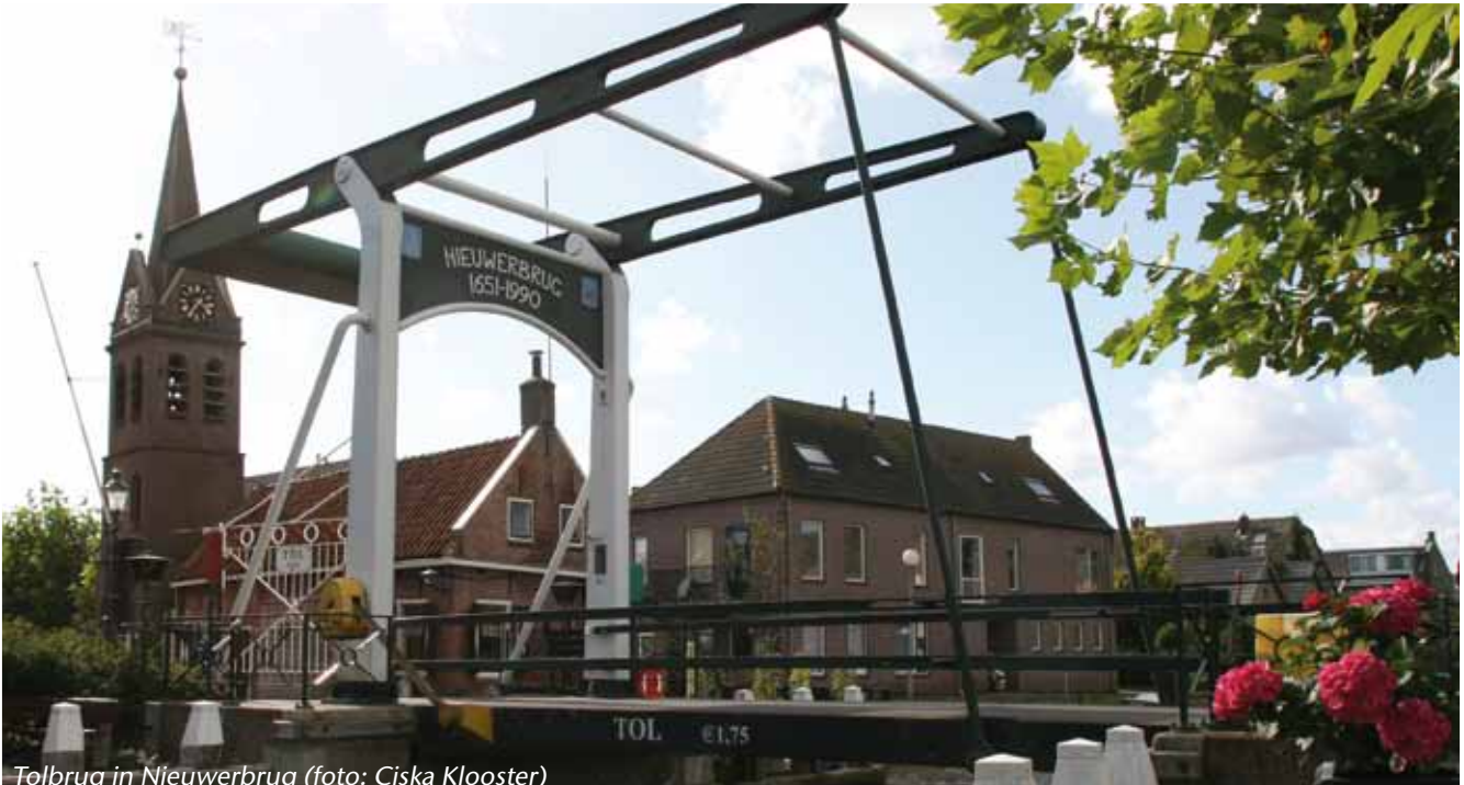
Tolbrug in Nieuwerbrug (foto: Ciska Klooster)
