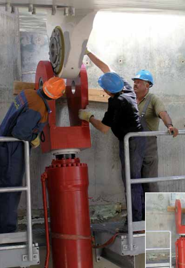
linksboven: monteren van de cilinder rechtsboven: rolbascule linksonder: cilinder rechtsonder: opzetinrichting van de oude brug
