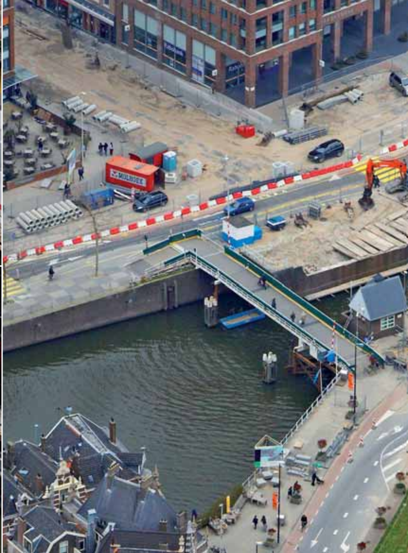
linksboven: aankomst brug in Rotterdam linksonder: plaatsing van de brug midden: luchtfoto van de verbouwing van de brug
