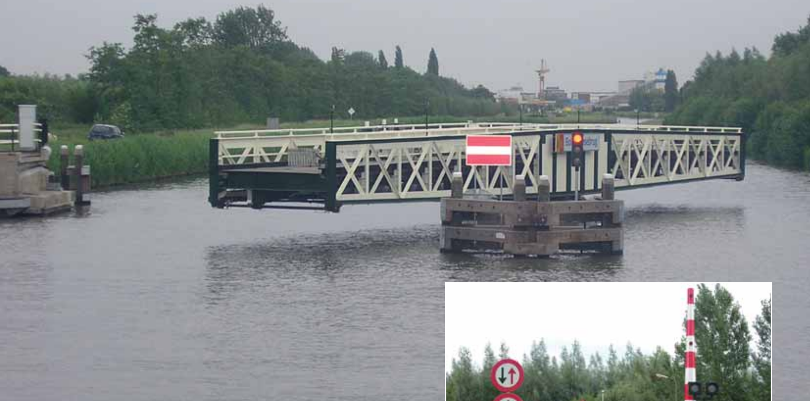
afb. 2 De brug in half open stand (foto ing. J. Stout) inzet: afb. 3 De brug gezien in de rijrichting
