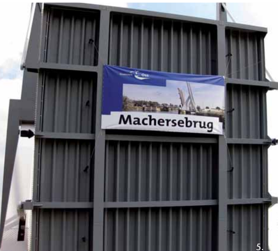
Afb. 5 : Val in geopende stand waarop de trogprofielen te zien zijn.
