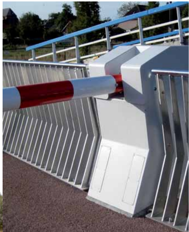
Afb. 6 : Roesvaststalen leuning met geborstelde stijlen en gepolijste bovenregel. Leuning onderbroken door een afsluitboomkast. De A-vorm van hameistijl en schoor ziet men hier terug.
