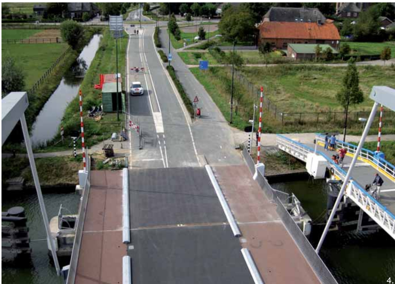
Afb. 4 : Bovenaanzicht van het wegdek met hoofdrijbaan en secundaire wegen, rechts de baan voor fietsers en brommers. Uiterst rechts de noodbrug.
