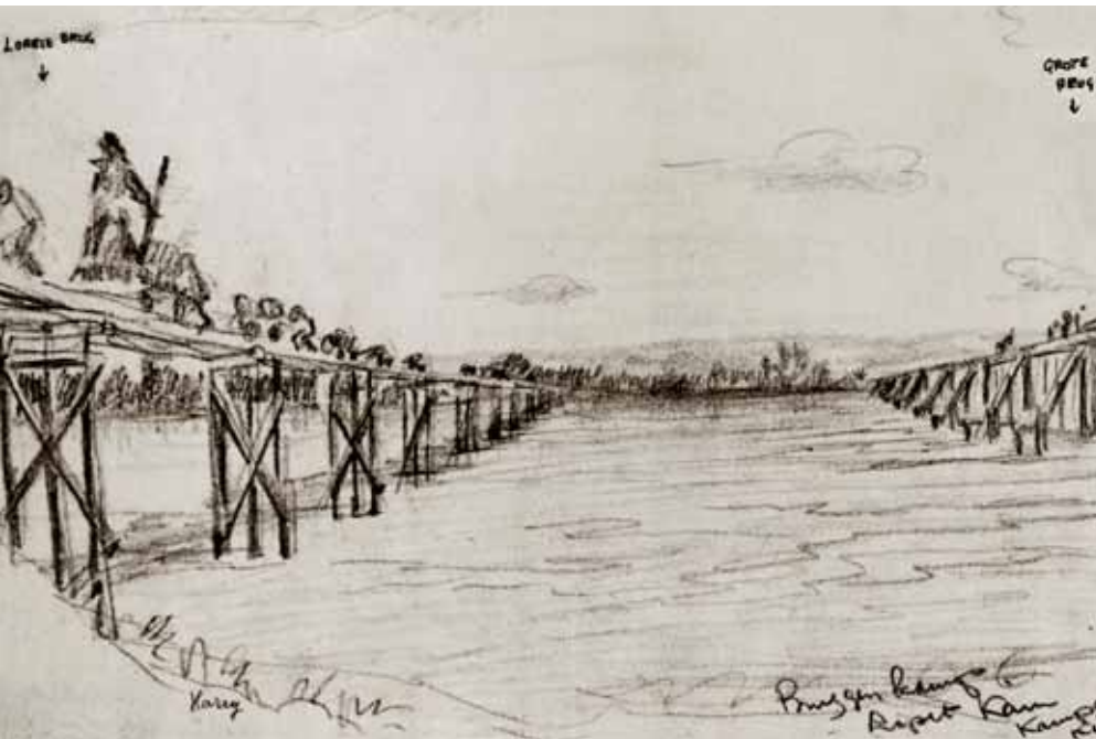
Nadat de brug over de Kampar Kiri bij Lipatkain op Goede Vrijdag 1945 bij een bandjir was weggespoeld, werd onmiddellijk begonnen met herbouw (rechts). Daarvoor moest eerst een noodbruggetje (links) worden geslagen.
