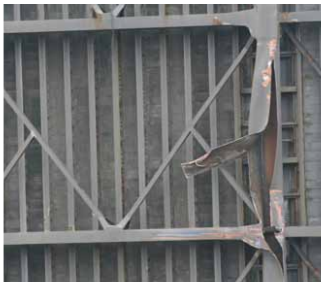
afb. 1 Schade na aanvaring
