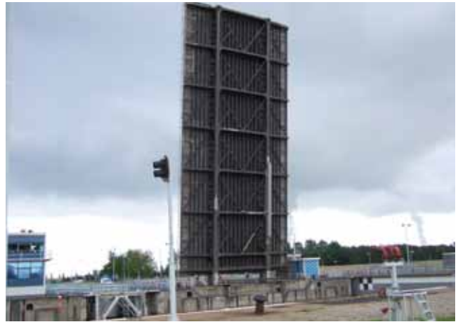
Tijdelijke balkconstructie aan hoofdlijger
