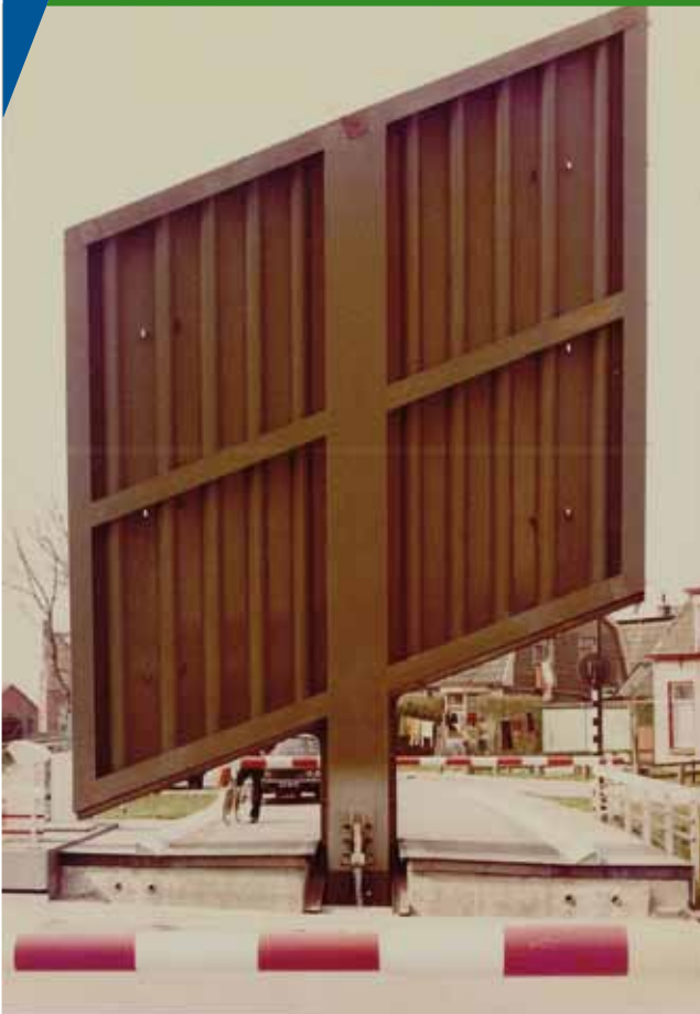
afb. 1. basculebrug Nes, ruitvormig
