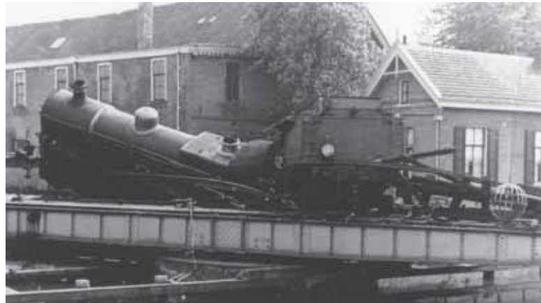
Opengedraaide brug over het Zijlsterdiep met ontspoorde locomotief
