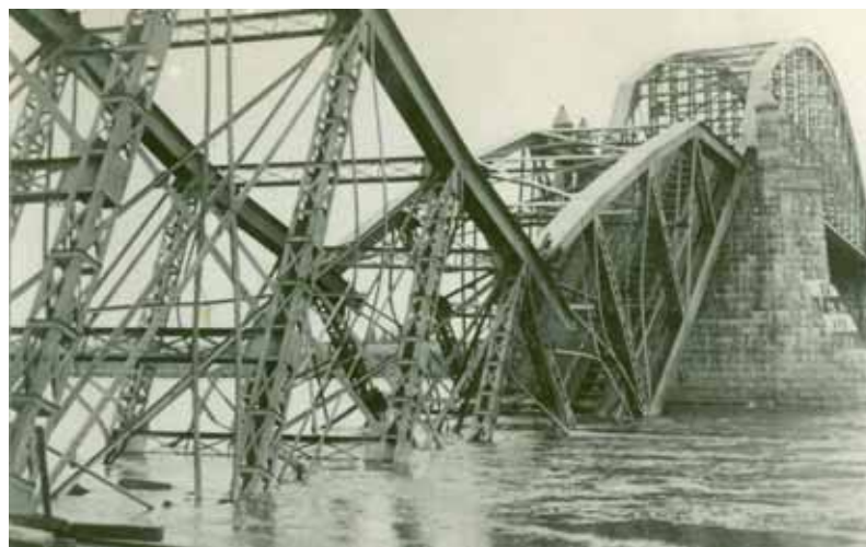
Vernielde overspanning in de spoorbrug bij Rhenen
