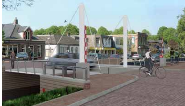
15. en 16. Kunststofbrug in Oosterwolde
