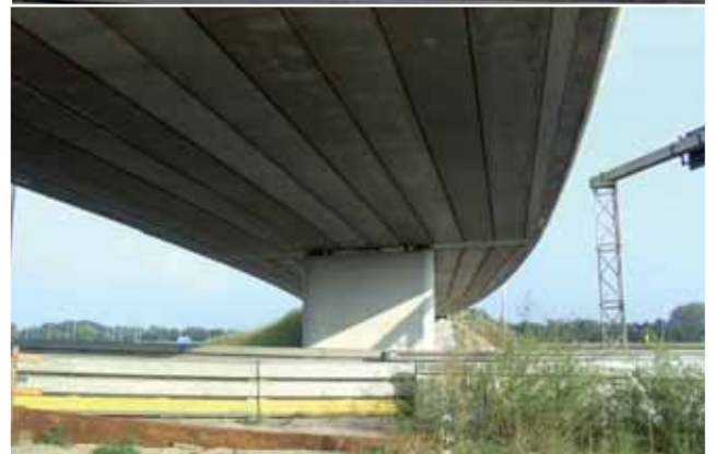
8. 9. en 10. Rondweg 's-Hertogenbosch in aanbouw
