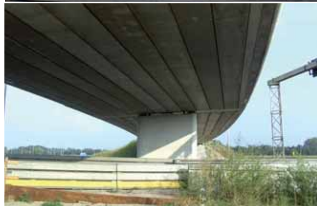
8. 9. en 10. Rondweg 's-Hertogenbosch in aanbouw
