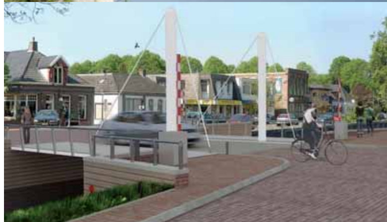
15. en 16. Kunststofbrug in Oosterwolde
