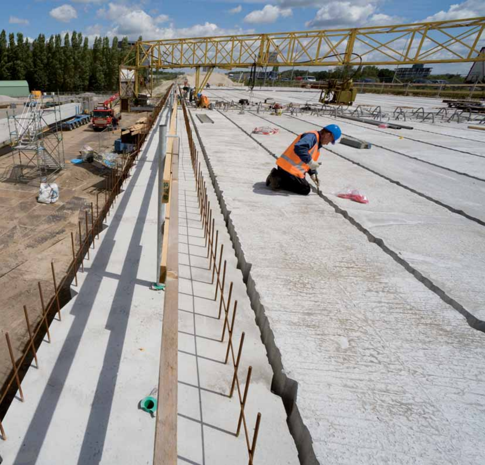
De aansluitende elementen vormen direct het brugdek
