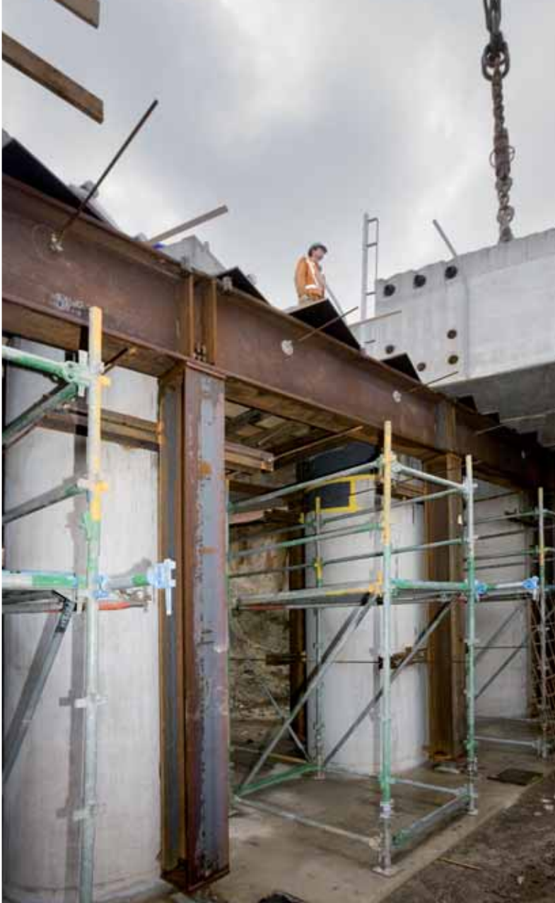
Overzicht van de stalen hulpondersteuning
