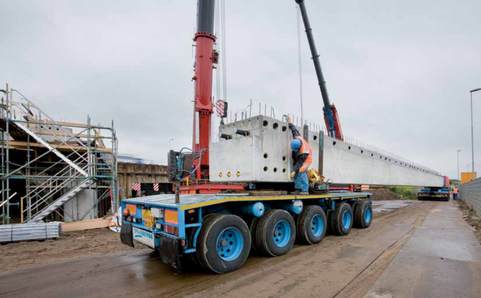
Aanvoer van de 52 meter lange kokerliggers
