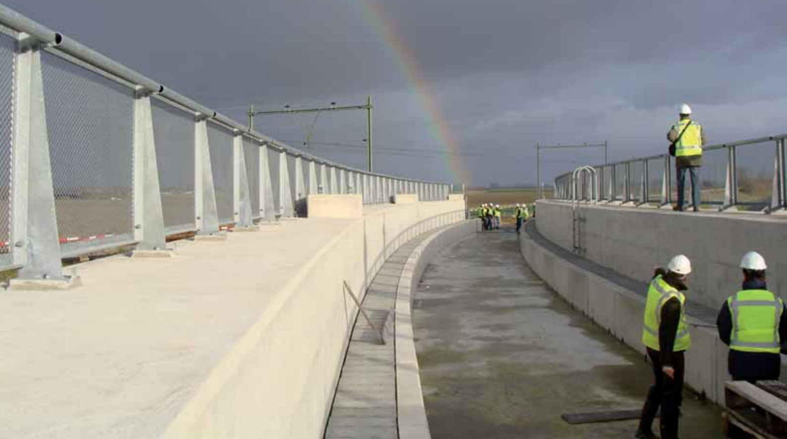
9. Situatie eind 2007, het betonwerk van de noordelijke brug is gereed, het ballastbed kan aangebracht worden, de opstorten op de buitenste randbalk zijn voor de later te plaatsen bovenleidingmasten.
