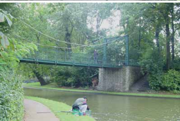
Boven: Brugdek van de hangbrug in stadspark Vilvoorde Onder: Aanzicht van de hangbrug in stadspark Vilvoorde
