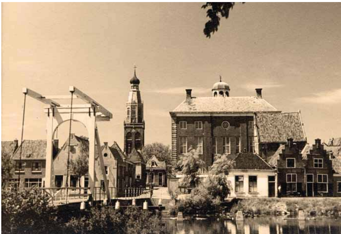
Compagniesbrug als enkele ophaalbrug Foto anno 1949
