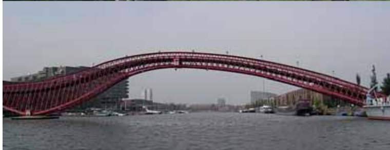
Van boven naar beneden: NBS deelnemers op de Nesciobrug. De Ennaeus Heermabrug, de toegang vanaf het centrum naar de nieuwe wijk IJburg. Nesciobrug, een fraaie vormgeving, ook van de afritten. Merkwaardig vormgegeven voetgangersbrug, de Borneobrug over de Spoorweghaven in de wijk Zeeburg.
