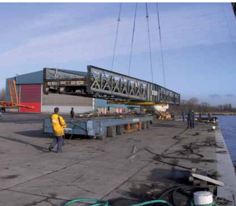
De draaibrug wordt op een vrachtwagen gehesen.
