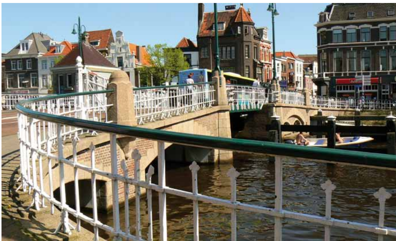
Detail van de brug met zicht op de Haarlemmerstraat (foto Boy Husinga)
