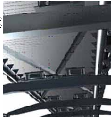
Afb. 17. Extra staalconstructie aangebracht aan de onderzijde van de rijvloer.
