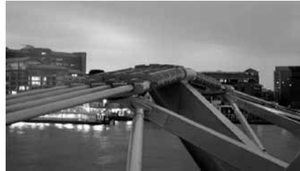
Afb. 15. Bevestiging van de kabels aan de pijlerconstructie.
