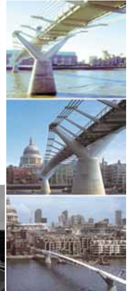
Afb. 14. De Londen Millennium bridge. De uitkragende liggers zitten om de circa 8 m.
