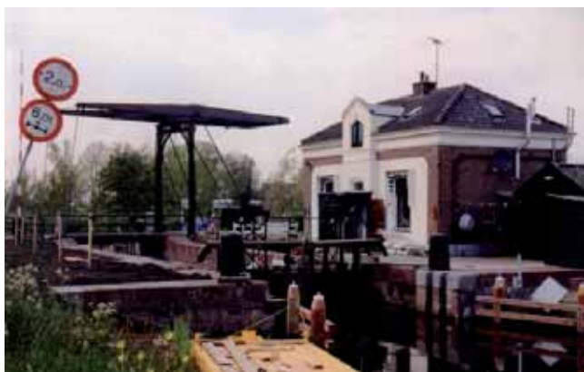
boven: De oplegging van de vaste betonbrug op de oostelijke kolkwand. Het metselwerk onder de brug is afgeboerd. midden: De vaste betonbrug over de Stolwijker Schutsluis met op de voorgrond het bewegingswerk voor de binnenschuif in het omloopriool tussen de kolk en het buitenhoofd. (herfst 2004)
