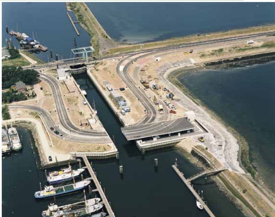
1. Overzicht van de bestaande ophaalbrug en de nieuwe Rolbrug.
