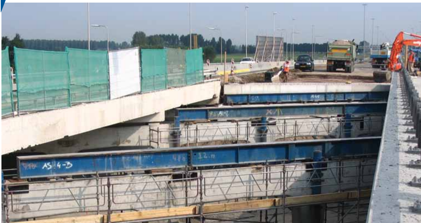
Tijdens het schuiven: het nieuwe brugdek nadert de dan nog in gebruik zijnde westelijke helft van het oude viaduct.
