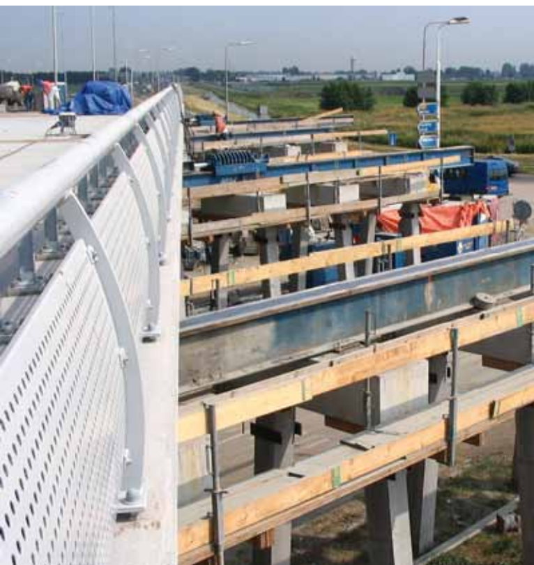
Tijdens het schuiven: op één van de schuifbanen is een schuifvijzel te zien.
