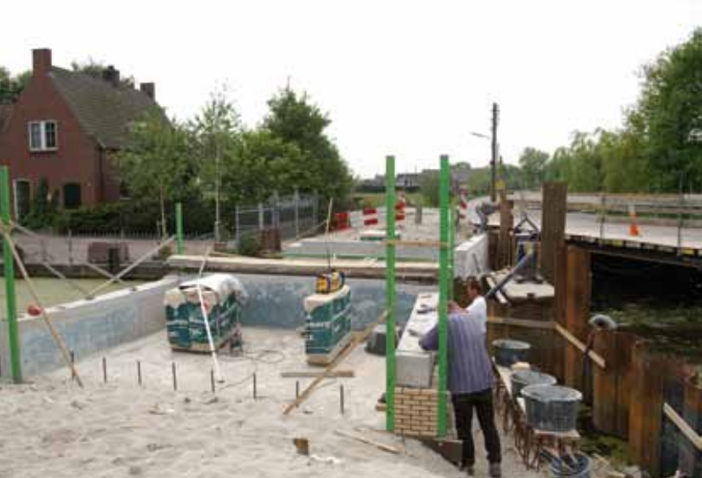
Linksboven: Kunststof model van een hoekstuk van de hameipoort geplaatst in de gietkast. (foto: De Kuiper Noordeloos) Rechtsboven: Het gieten van een van de hameistijlen. (foto: De Kuiper Noordeloos) Linksonder: De gewapend betonnen onderbouw. Linksmidden en rechtsonder: Opmetselen van de baksteenbekleding.
