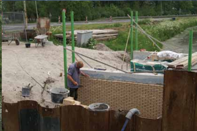
Linksboven: Kunststof model van een hoekstuk van de hameipoort geplaatst in de gietkast. (foto: De Kuiper Noordeloos) Rechtsboven: Het gieten van een van de hameistijlen. (foto: De Kuiper Noordeloos) Linksonder: De gewapend betonnen onderbouw. Linksmidden en rechtsonder: Opmetselen van de baksteenbekleding.
