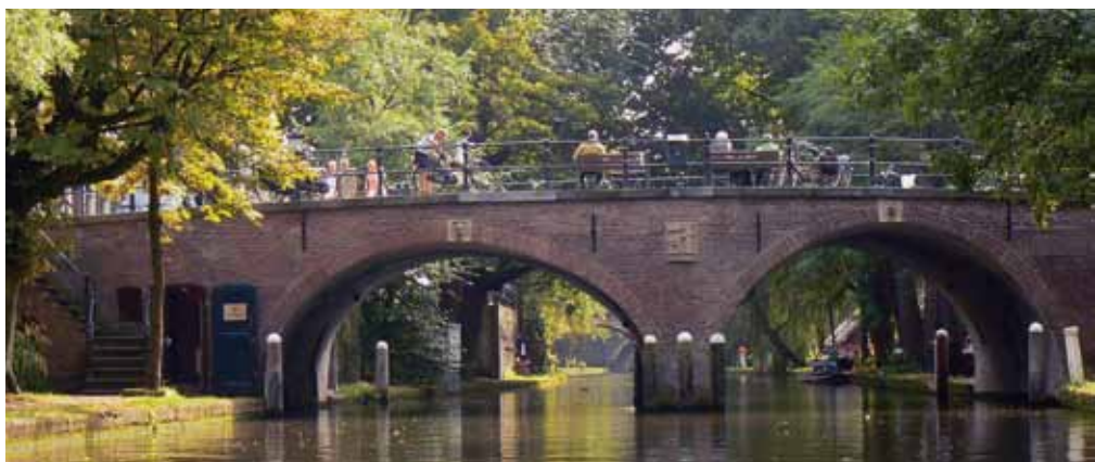
Utrecht, Zuiderbrug en daaronder de Smeebrug Foto's: E.J. Huisinga
