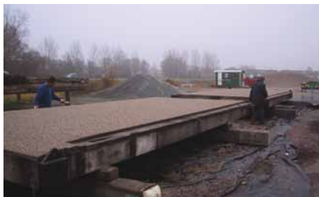
De vlotbrug van een nieuwe slijtlaag voorzien.
