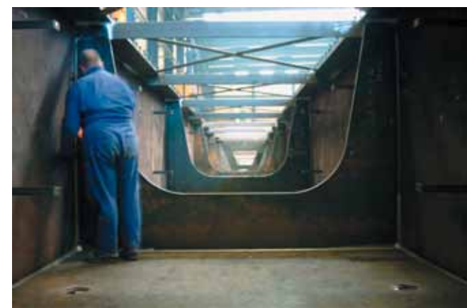
Doorsnede stalen onderconstructie tijdens de fabricage.
