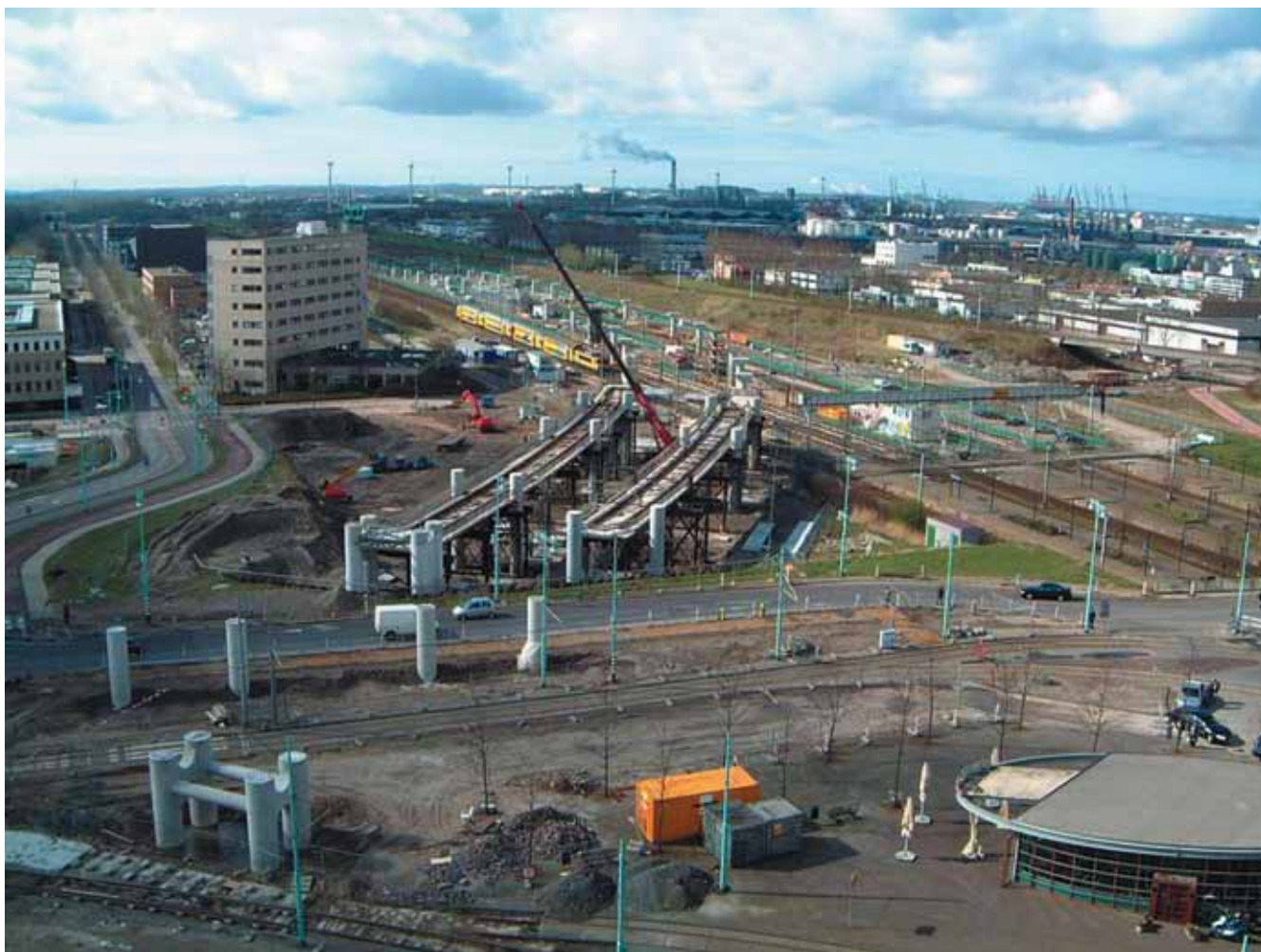
Lanceerplatform van bovenaf gezien.
