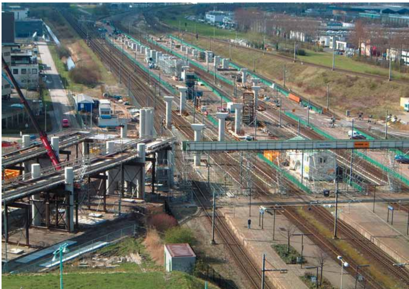
Overzicht van de Hemboog in aanbouw.
