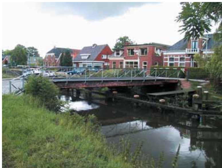
Overzicht oude draaibrug zuidzijde
