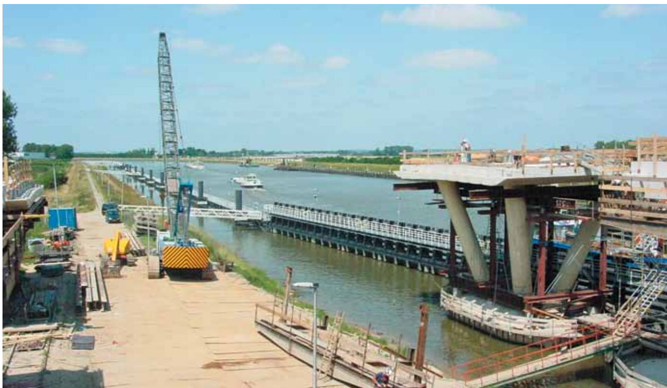
V-vormige ondersteuning bij de spoorbrug over het Amsterdam-Rijnkanaal bij Tiel
