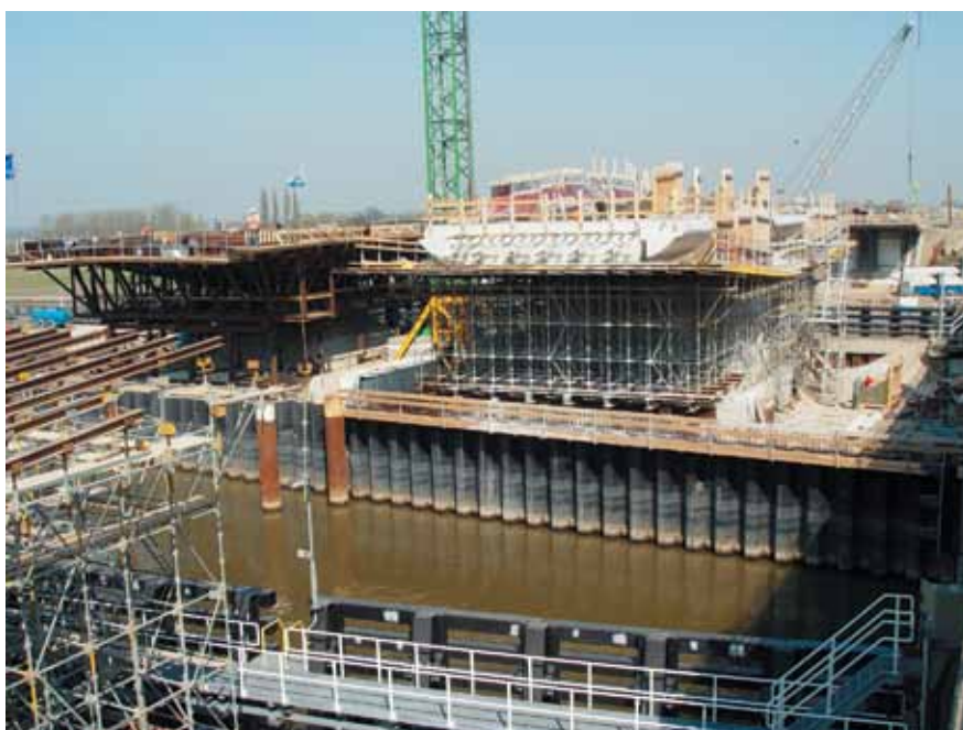
Spoorbrug over het Amsterdam-Rijnkanaal in aanbouw
