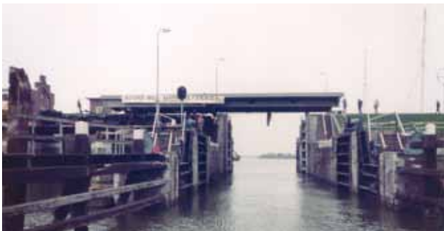
Boven: Plaatsing val van de basculebrug in 1982. rechts boven: Basculebrug in open stand. Het draaipunt ligt boven de doorgang naar de uitwateringssluis. rechts onder: Onderzijde brug met hydraulische cilinders van het bewegingswerk.
