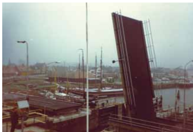
Boven: Plaatsing val van de basculebrug in 1982. rechts boven: Basculebrug in open stand. Het draaipunt ligt boven de doorgang naar de uitwateringssluis. rechts onder: Onderzijde brug met hydraulische cilinders van het bewegingswerk.
