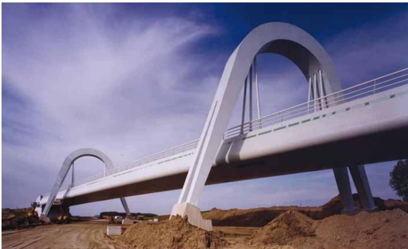
Figuur 2 Hangtrogbrug Terneuzen
