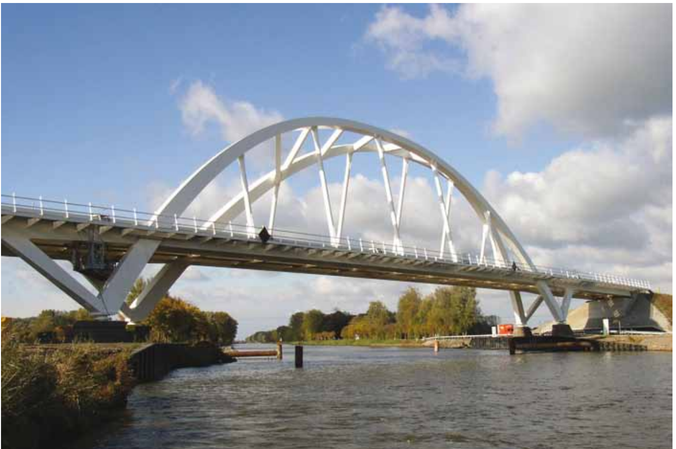
Figuur 1: Aanzicht spoorbrug over het Van Starckenborghkanaal
