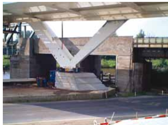
Figuur 6: De brug op tijdelijke ondersteuning na het aflaten
