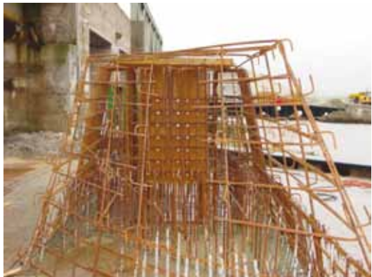
Figuur 5: De stalen doek met deuvels in nog niet voltooide wapeningskorf
