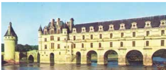
Afb. 2. Voorbeeld van een landelijke brug; Chenonceaux in de Loirevallei.
