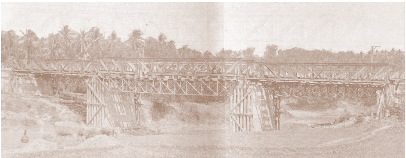
Gezicht op de nieuwe bruggen, kort na de montage. Bij de middenoverspanning bevindt de montagebrug zich nog onder de nieuwe brug, bij de eindoverspanningen zijn deze reeds onder de oude bruggen geschoven.
