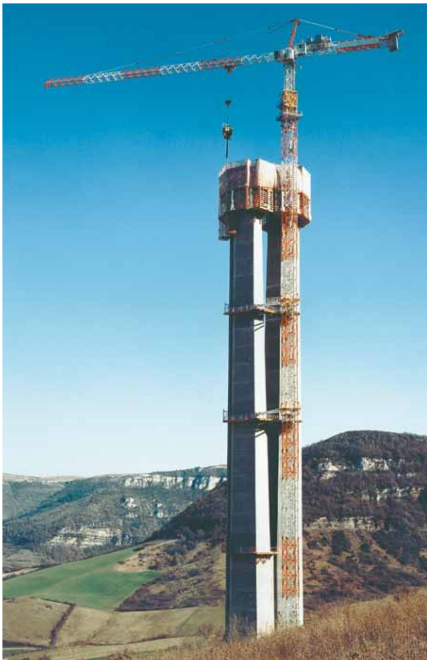
Foto Pijler van de brug bij Millau Lees meer over de brug bij Millau op pagina 24
