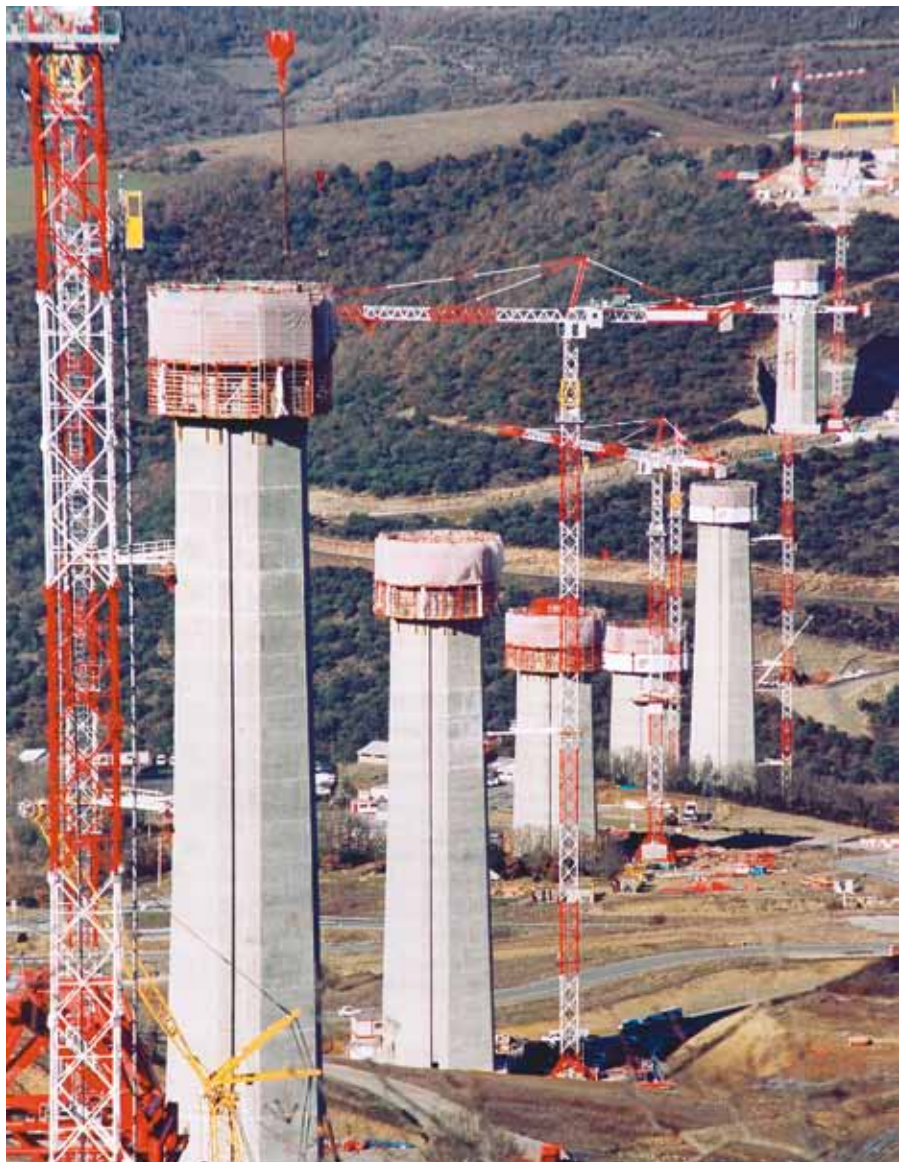
In aanbouw zijnde pijlers voor de brug bij Millau
