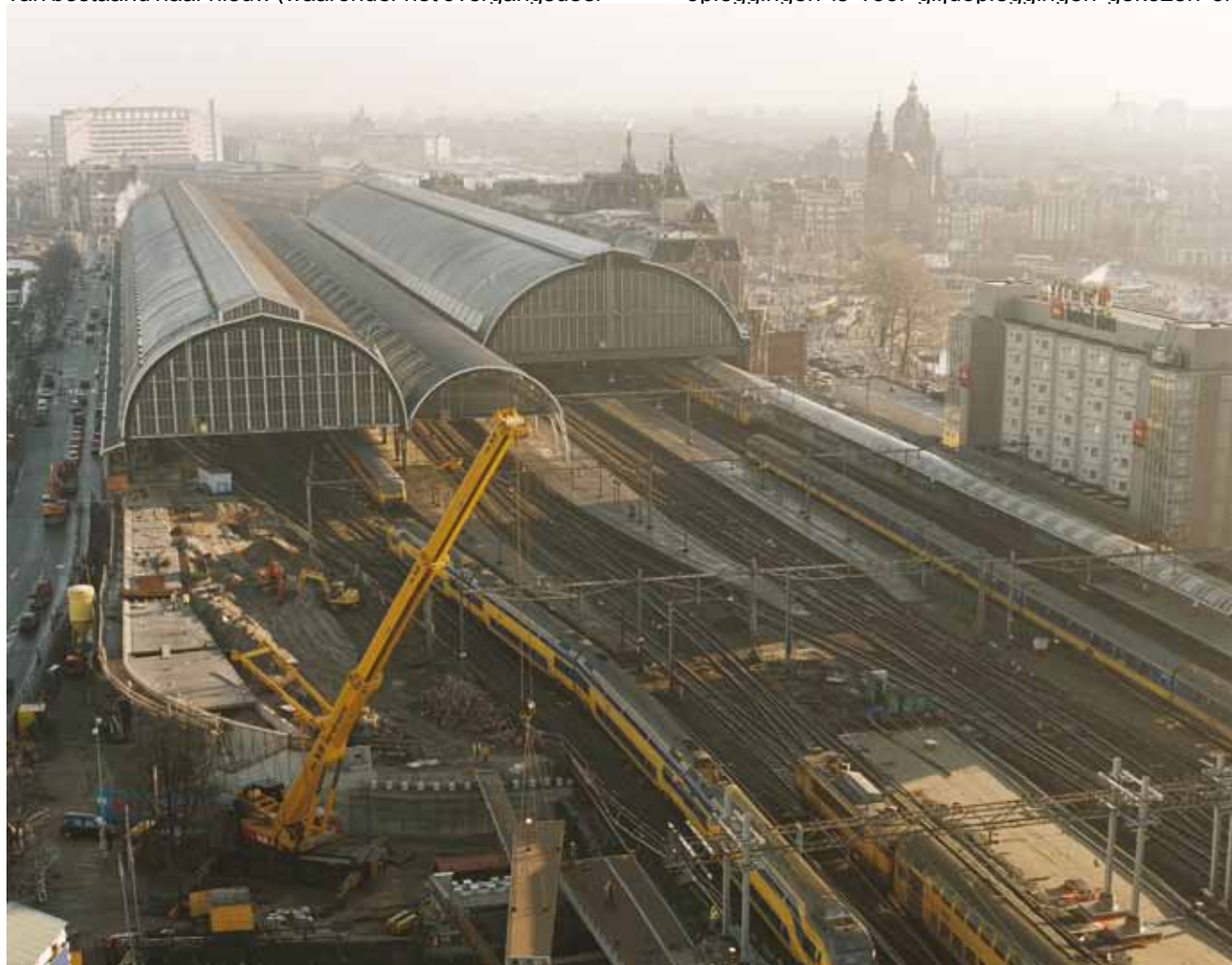
Figuur 4: montage noordelijke verbreding
