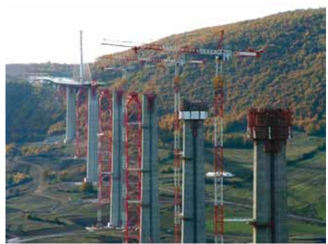
Figuur 9: de S-bocht in het dek is goed te zien
