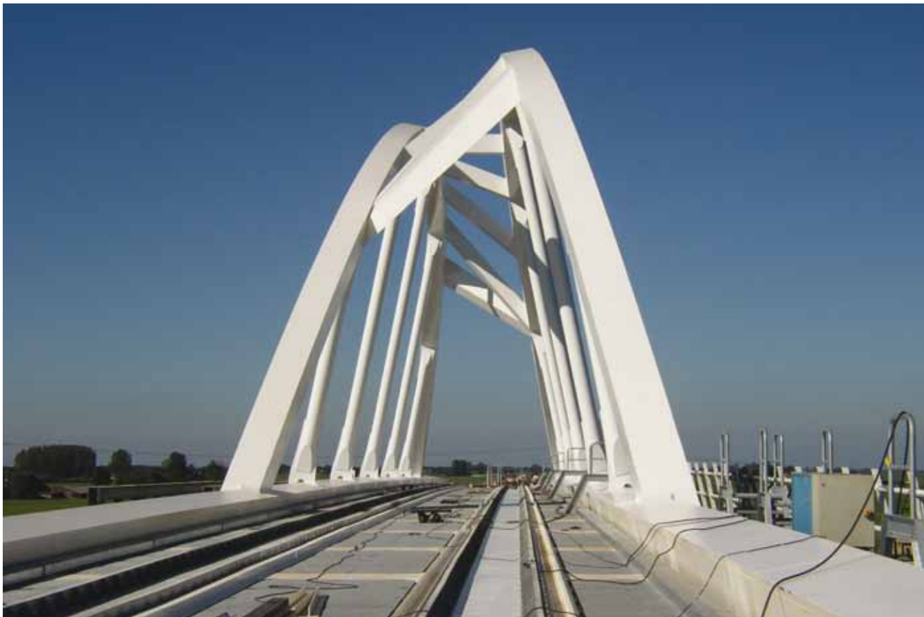
Figuur 2: De scheefstand van de bogen in dwarsrichting
