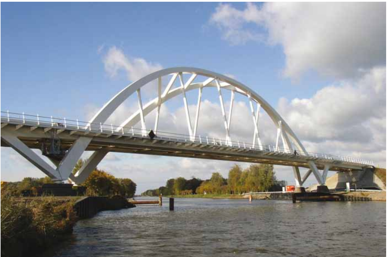
Figuur 1: Aanzicht spoorbrug over het Van Starckenborghkanaal
