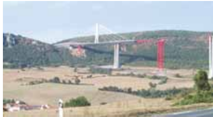
Figuur 10: doorbuiging van het dek als gevolg van het gewicht van de pyloon
