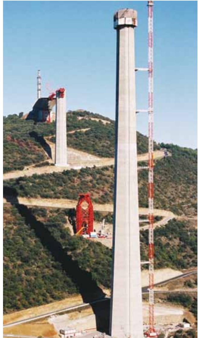
Figuur 3: bouw van de pijlers
