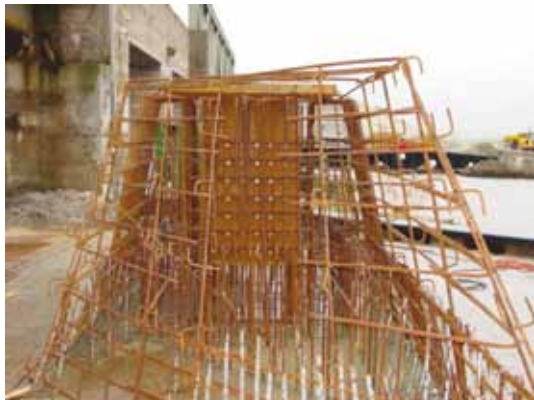
Figuur 5: De stalen dook met deuvels in nog niet voltooide wapeningskorf
