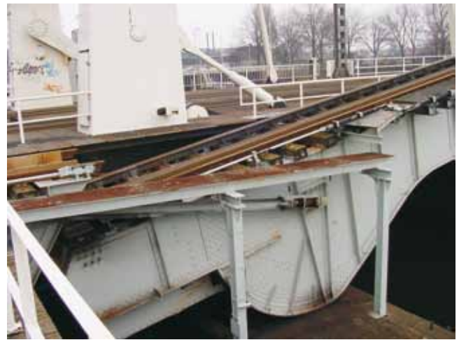
Aan de trekstang wordt de rolbasculebrug opengetrokken.
