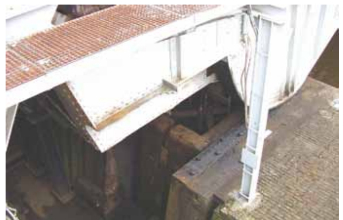
De rol loopt over een rollenbaan met nokken om de brug op zijn plaats te houden.
