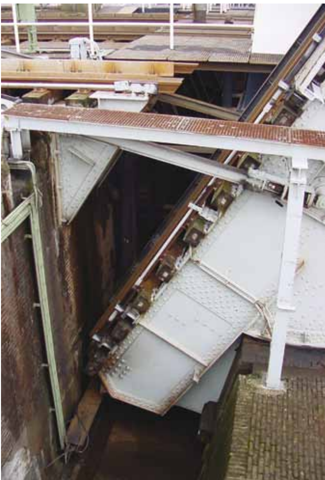
Afgeschuinde staart van de brug past in gesloten stand tegen de afschuining aan de basculekelder.
