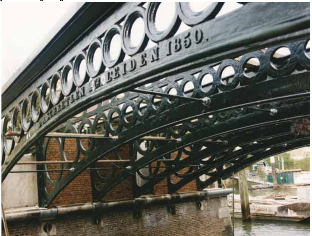
Gietijzeren liggers van de Nieuwbrug.
