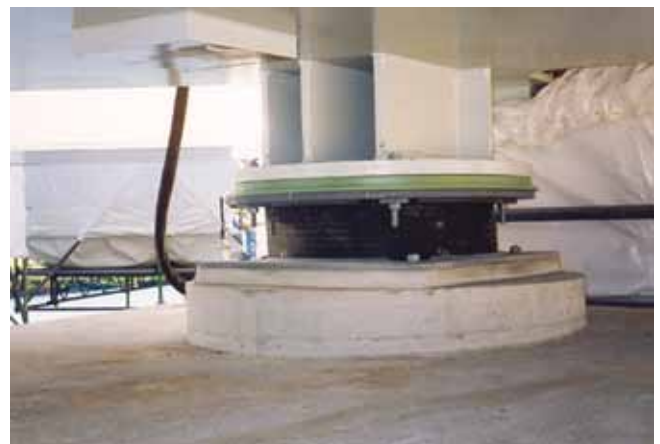
Rubber oplegging toegepast bij de staal-betonnen brug Veghel.
