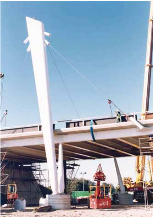
Pyloon met tuikabels
