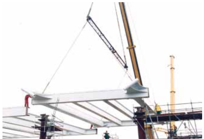
Inhijzen brugdeel. Let op aansluitingspunt voor de tuikabel
