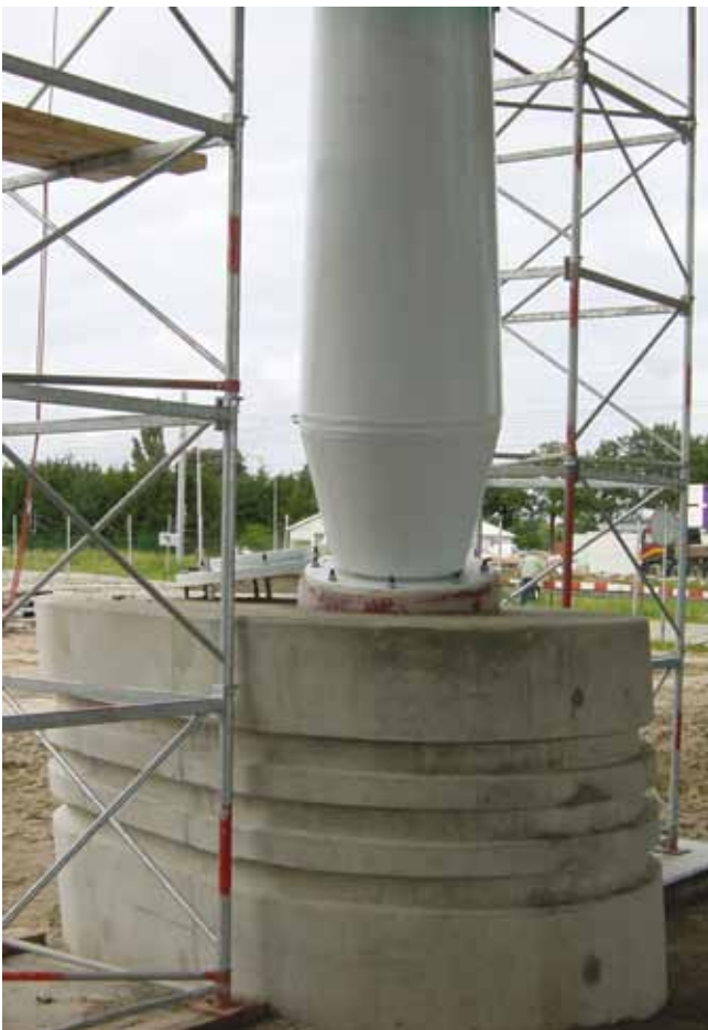
Fundering van de pyloon
