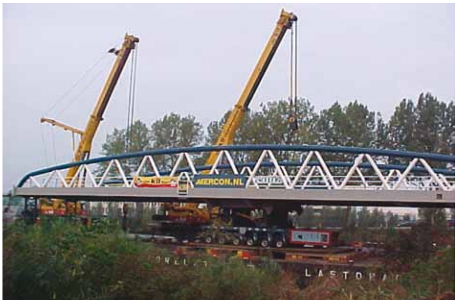
Inhijzen nieuwe brug
