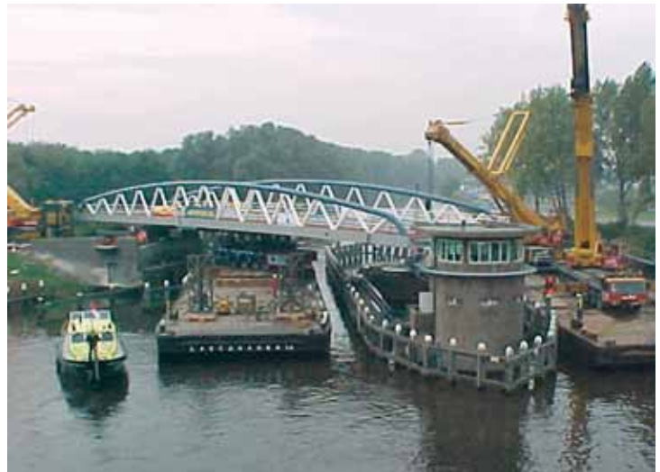
Inhijzen nieuwe brug
