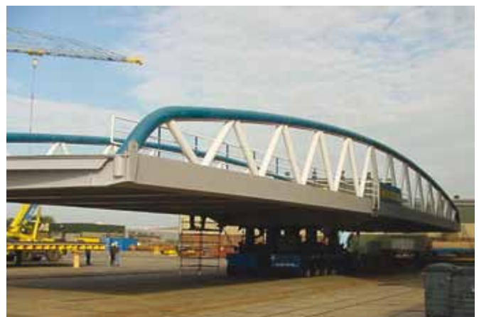
Nieuwe brug op rolplateau gereed voor vervoer naar de bouwplaats
