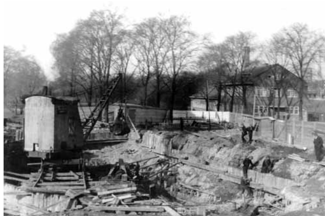
Bouw van de Mirakelbrug in 1928
