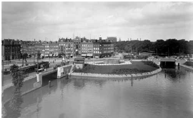
Het Nassauplein, links brug 151 en rechts brug 152, de Mirakelbrug met rechts daarvan het toegangshek naar het Westerpark. (foto P.W., afdeling Bruggen)
