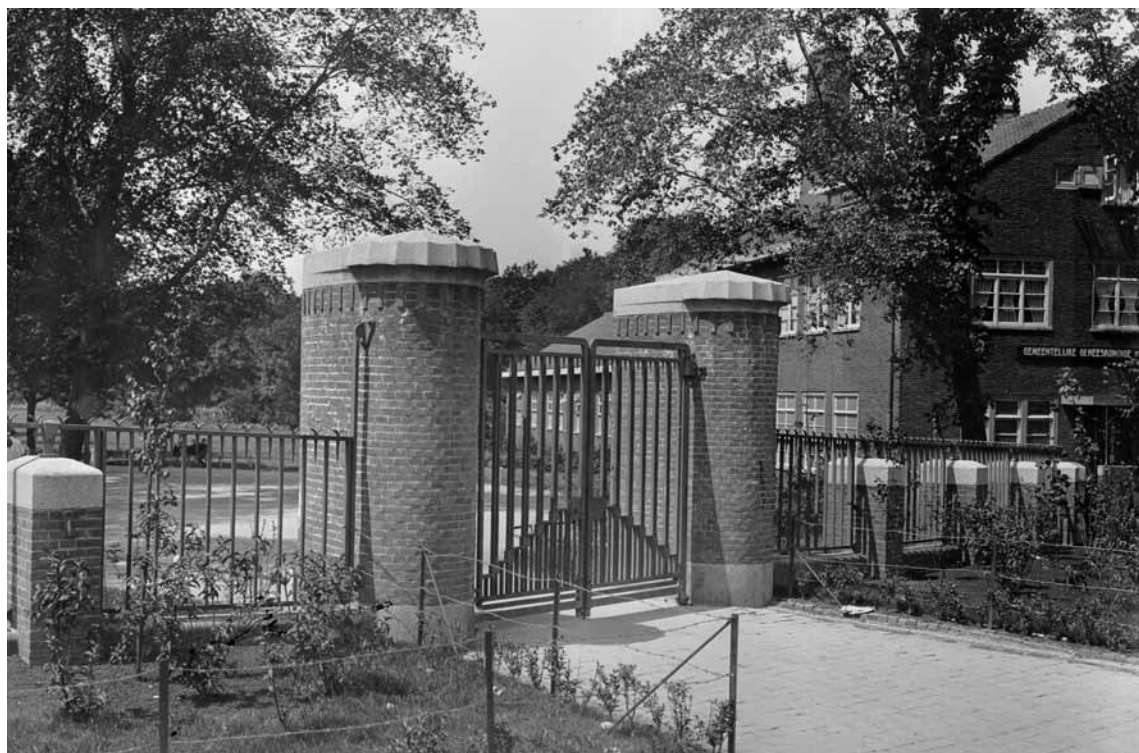
Ingang geneeskundige Dienst. Nu toegang tot het Westerpark. (foto P.W. Afdeling Bruggen)
