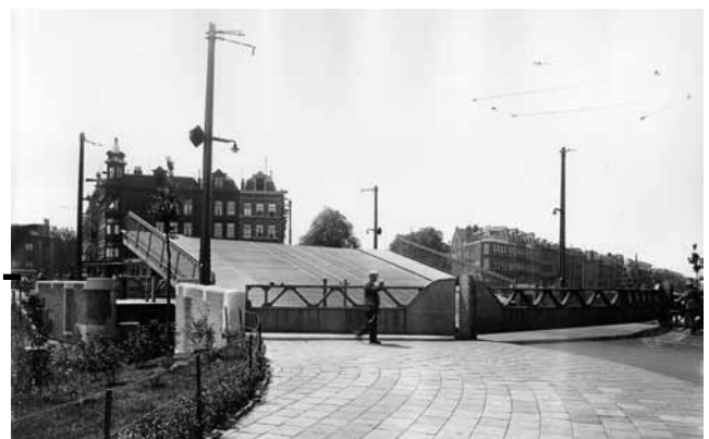
De basculebrug uit 1928. Er is nog geen bovenleiding op de brug aangebracht. (foto P.W., afdeling Bruggen)
