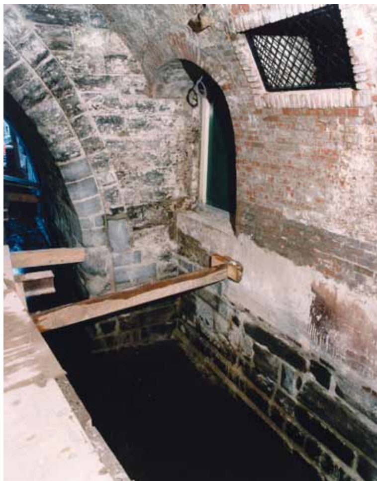
Detail van de aansluiting van het 16e eeuwse brugdeel op de Huidenbrug. De natuurstenen voet onder de 16e eeuwse brug is het restant van een hoog opgaande muur, waarvan de intanding in het front van de Huidenbrug nog te volgen is. (Fotodienst het Utrechts Archief)
