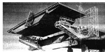
Figuur 12. Assemblage hoofdliggers Dintelhaven spoorbrug. (links)
