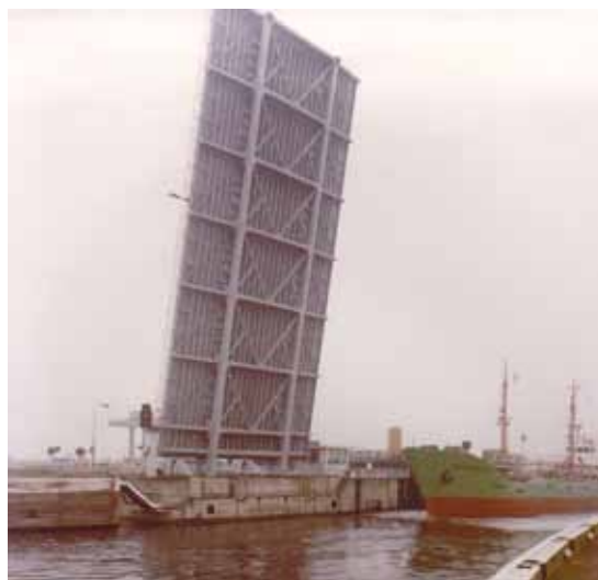
Basculebrug over de Westsluis in Terneuzen.
