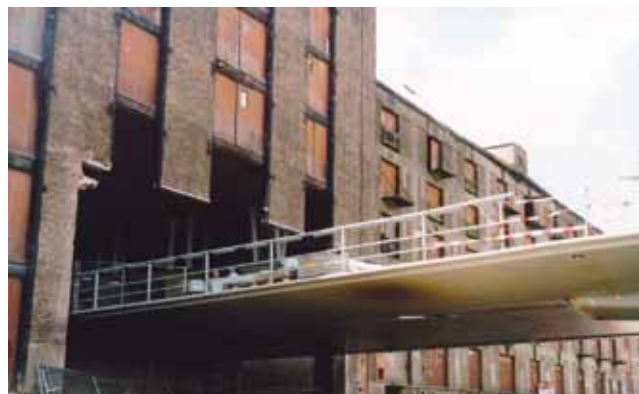
De toegangsweg naar de Jan Schaefferbrug breekt meedogenloos door het monumentale pakhuis (foto E. Zoutendijk).
