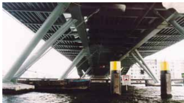
De Jan Schaefferbrug naar het Java-eiland, Amsterdam (foto E. Zoutendijk).
