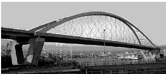
Figuur 8 Verkeersbrug bij Osaka: type Nielsen-Lohse
