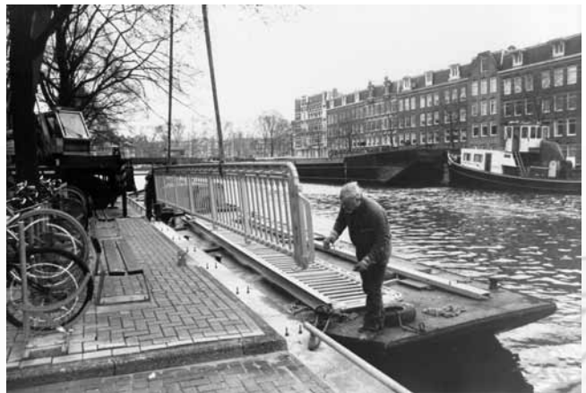
De oude leuningën, die tijdelijk dienst hebben gedaan als kadehek zijn weer geschikt gemaakt voor de nieuwe brug.
