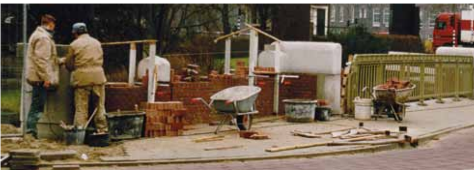
Het metselen van de borstwering
