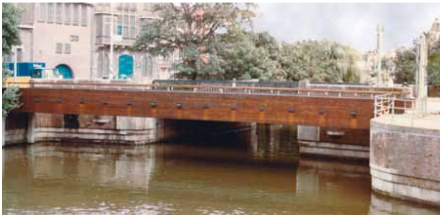
De brug van Kramer gaat geheel schuil achter de houten voetbrug.
